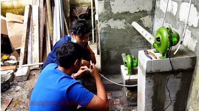
Gambar 5. Pemasangan dan pengawatan Blower untuk menghembuskan udara panas ke ruang pemanas
