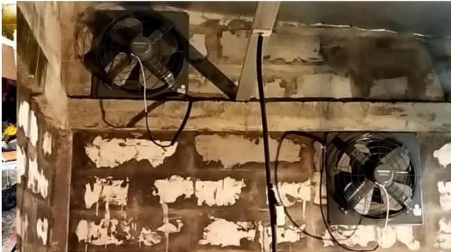
Gambar 6. Pemasangan Exhaust Fan untuk membuang udara panas ke luar ruang pemanas
