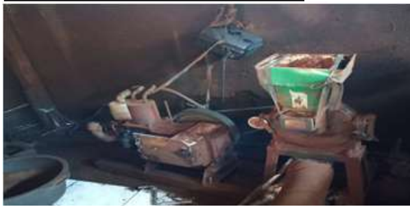
Gbr 4. Kondisi Mesin Penggiling dan Sealer
