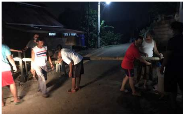
Gambar 6 Gotong Royong Warga Perumahan membangun portal
