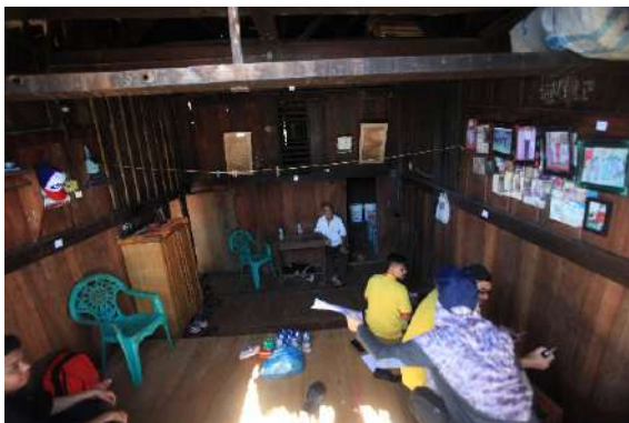
(a). Pengukuran dinding kayu.
