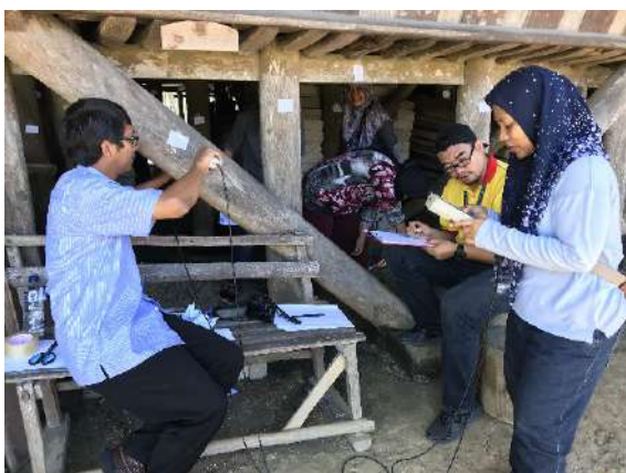
(b). pengukuran tiang breising kayu.
