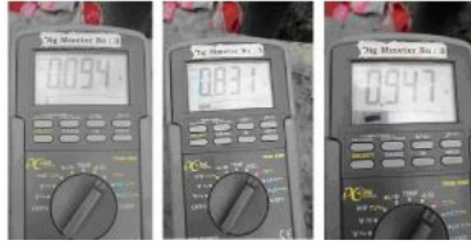
Gambar 10. Pengukuran arus bagian slave (pintu air).
