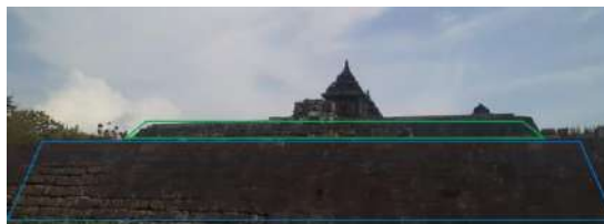
Gambar 8. Dinding Teras I, II, dan III
